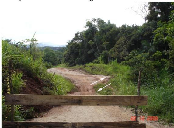
Figura 6: Estrada deslocada lateralmente pelo movimento de uma massa de solo em rastejo. A massa que movimentou (movimento da direita para a esquerda) é a que está abaixo da linha de descontinuidade da estrada.
