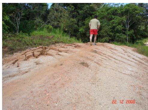
Figura 5: Elevação de frente de rastejo em estrada, exibindo fendas de tração devido ao soerguimento.
