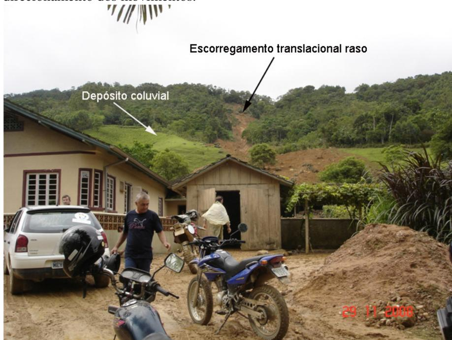
Figura 14: Residência danificada por escorregamento translacional raso (ao fundo). Observa-se que o escorregamento assentou-se sob depósito coluvial rico em matacões, formado por deslizamentos antigos, provavelmente do mesmo tipo.
